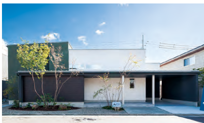
▲平屋と2階建てからなる建物の水平ラインを強調した外観は、異素材のアースカラーの組み合わせで自然になじむテイストに（RSK/バラ園展示場）
